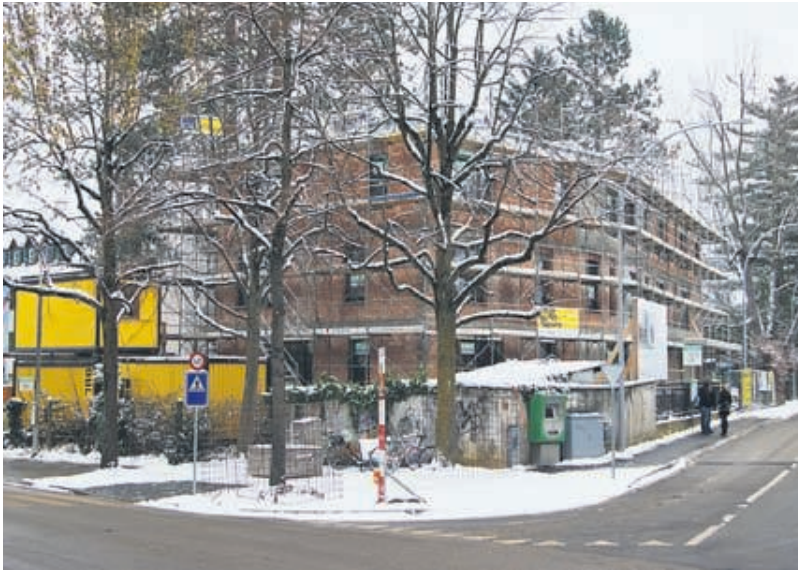
Die «Weisse Villa» wurde im Sommer abgerissen und ist nun durch einen Neubau ersetzt worden.
